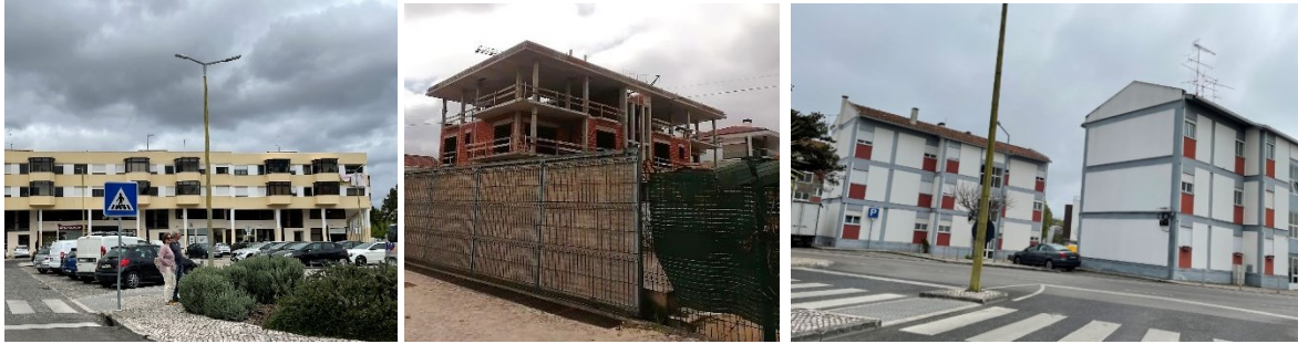
Centro da Freguesia da Batalha (imagens SPI, abril 2022)
