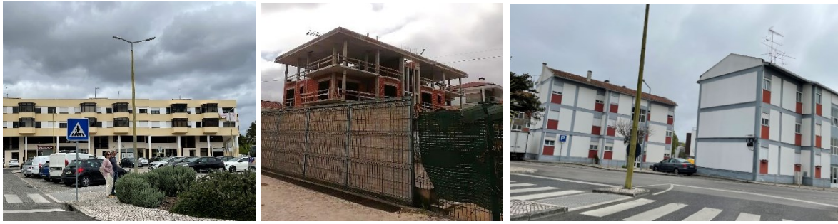
Centro da Freguesia da Batalha (imagens SPI, abril 2022)
